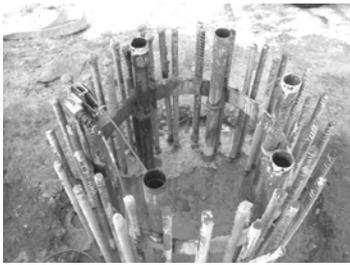
**Abbildung 7:** Kopf eines Sekundärpfahl mit Zugangsröhren
