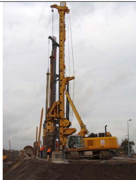
**Abbildung 3:** Bau der überschnittenen Bohrpfahlwand an der Schleuse Dörverden (Foto: BAM).
