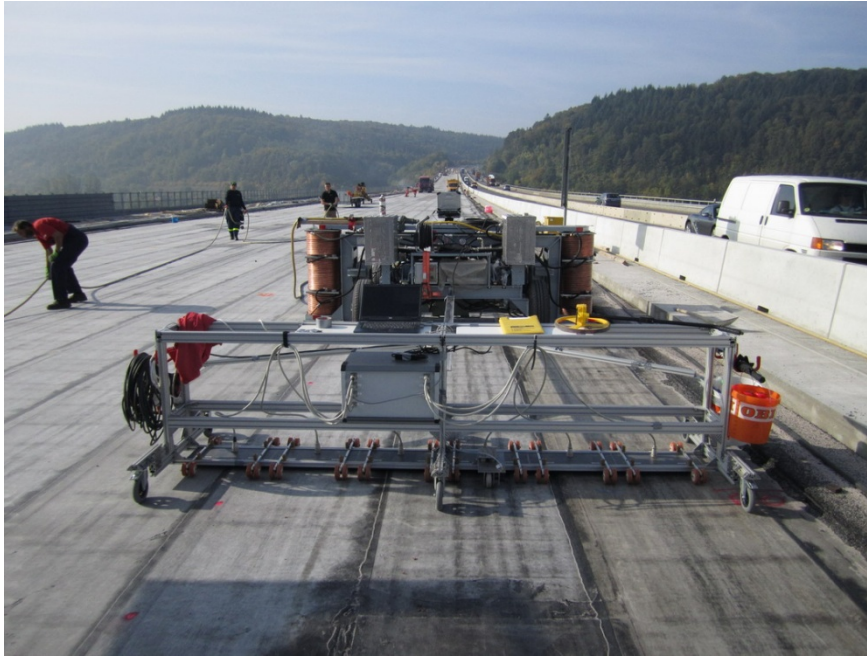
Bild 6. Messen der Querspannglieder mit dem 3 m breiten Linienscanner hinter dem Großmagneten auf einer Autobahnbrücke.
