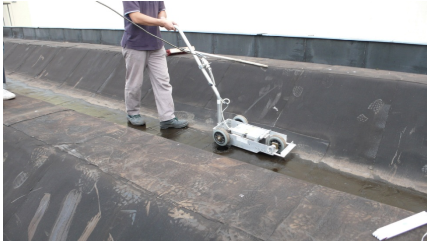
Bild 1. Messen von VT-Falten. Zunächst wurde die Magneteinheit auf der Oberseite des Dachs über die Projektion der Spanndrähte geführt, anschließend wurde wie im Bild gezeigt die Sensoreinheit über die Oberfläche geführt. Das zu einer integrierten Magnetisier- und Messeinheit weiterentwickelte Gerät zeigen die Bilder 2 bis 4.
