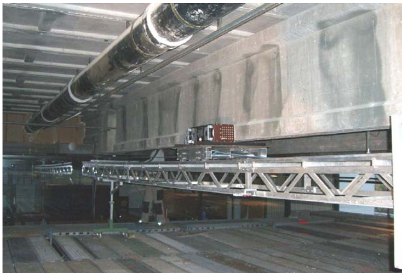
Bild 3. In Schwimmhallen können die in der Atmosphäre aus der Desinfektion stammenden Chloride für Spannstähle kritisch werden. Im Bild sind Magnet und Sensoreinheit auf einer Leichtmetallkonstruktion zur Messung des Binderuntergurts.
