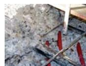
Freigelegte Heizleitungen und Rissebene im Betonbauteil
