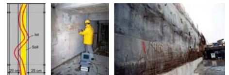
Oben: Verschobene Lage der Schalldämmung (links); Messung der Wanddicke (Mitte); verbliebene Wandschale nach Abriss der zweiten Schale (rechts)
