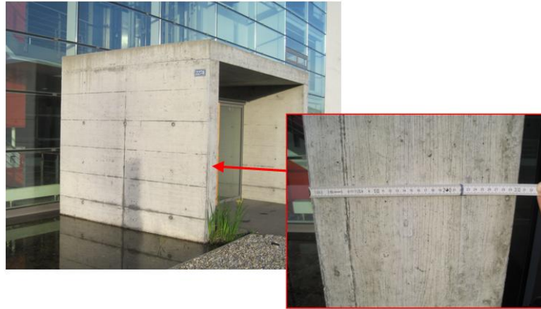
Abbildung 7: 30 cm dicke Testwand aus Beton. Alle Messungen wurden in ungestörten Bereichen, d.h. Bereichen ohne Einbauten wie beispielsweise Entwässerungsrohren durchgeführt.
